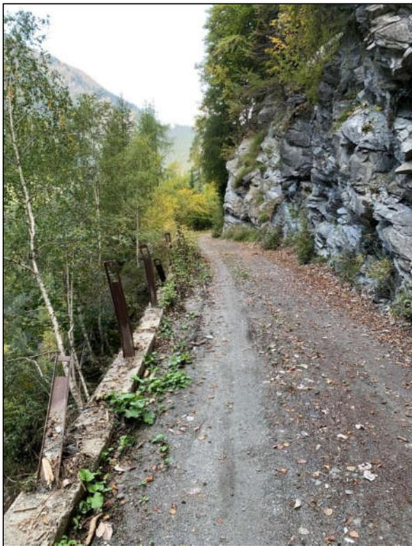
Instabile (schräge) talseitige Stützmauer
