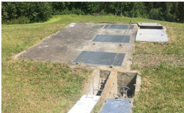
Die ARA Dutjen erfüllt die gesetzlichen Anforderungen nicht mehr. Die ARA besteht momentan lediglich aus einem Emscherbrunnen (auch Klärgrube genannt), d.h. aus einer Absetzanlage mit getrenntem Schlammfaulraum. Verlangt wird eine Umrüstung in eine aerob biologische Anlage. Ohne Sanierung können keine weiteren Anschlüsse im Einzugsgebiet bewilligt werden. Aus diesem Grund hat der Gemeindevorstand das Ingenieurbüro AFRY Schweiz AG mit der Ausarbeitung eines Sanierungsprojektes beauftragt.
