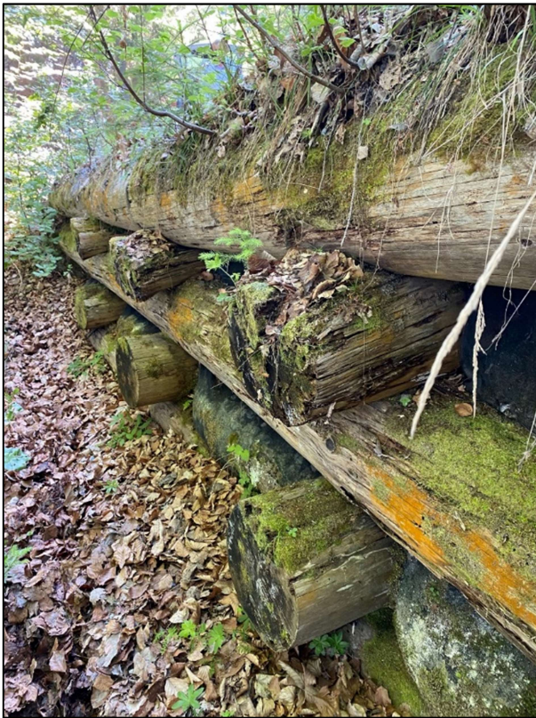
Bild 1: Fauler Holzkasten mit geringer Tragfähigkeit (Waldweg Fahn)
