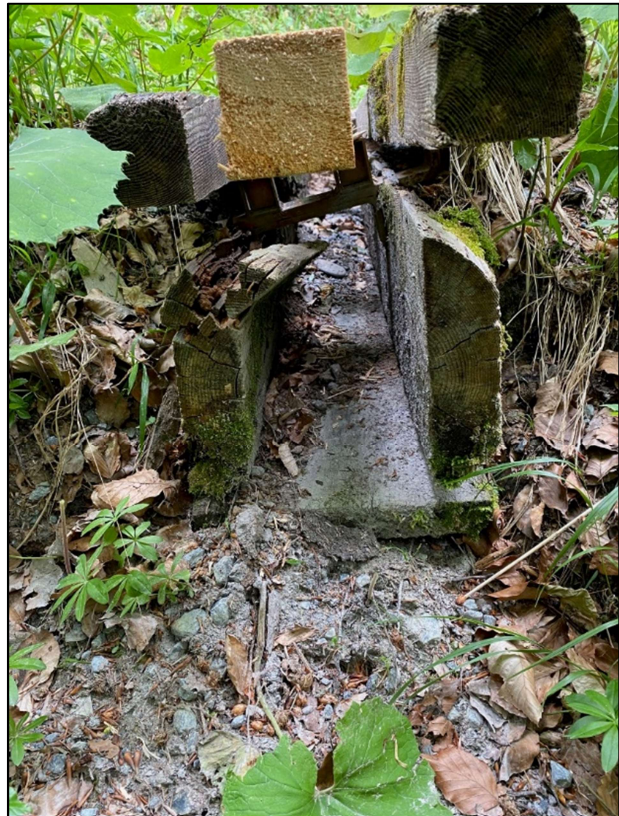
Bild 1: Fauler Holzkasten mit geringer Tragfähigkeit (Waldweg Fahn)
