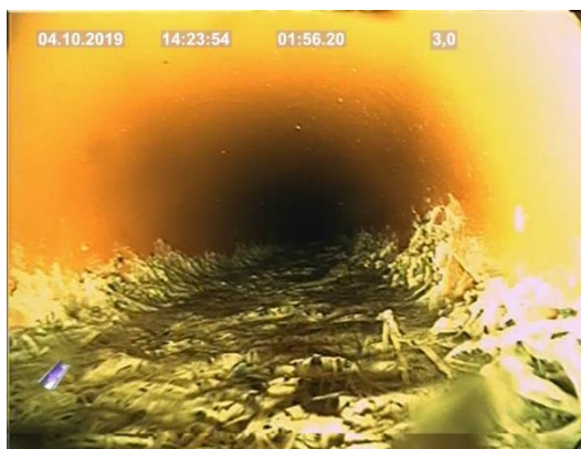
Wurzeleinwuchs Fassungsleitung
